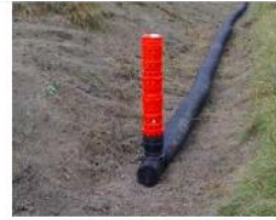
Source: Georges Lamarre (MAPAQ) Pose de l'avaloir et de la canalisation
